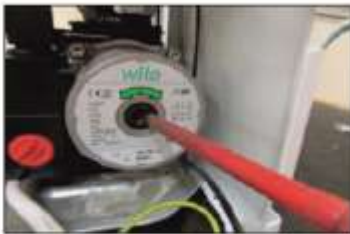
4. Используя отвертку, проверните ротор влево и вправо
