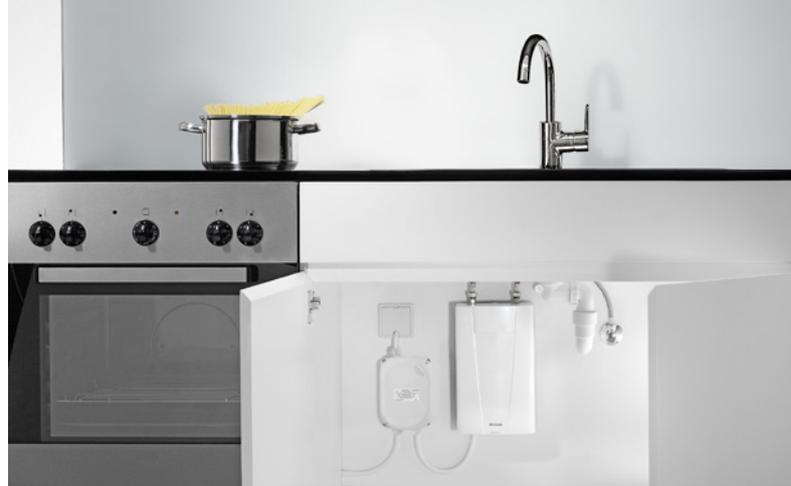
Данный водонагреватель не предусматривает возможности управления его работой: нагрев воды регулируется надежной электроникой прибора. Мощность нагрева автоматически изменяется в зависимости от объемного расхода и температуры поступающей в прибор воды. В ходе повседневной эксплуатации температура регулируется посредством смесителя.
