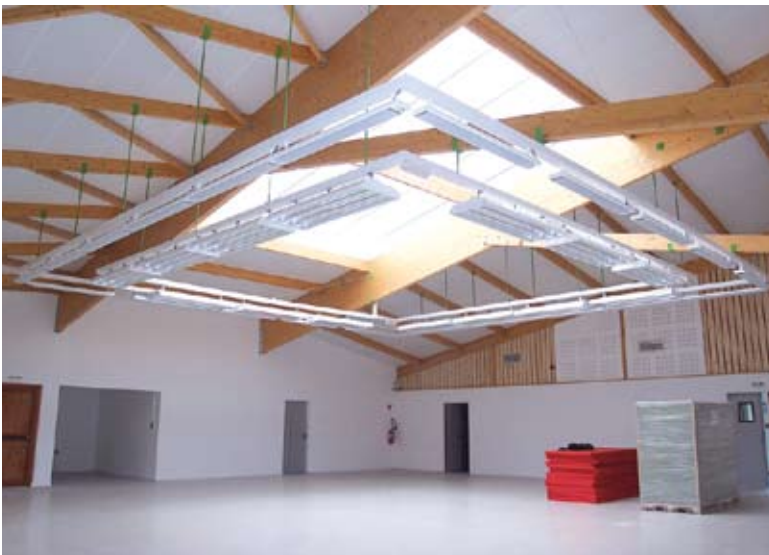
Инфракрасные обогреватели – это оптимальное решение для обогрева периодически используемых помещений. Смелое дизайнерское решение делает компоновку систем освещения и обогрева самостоятельным архитектурным элементом.
