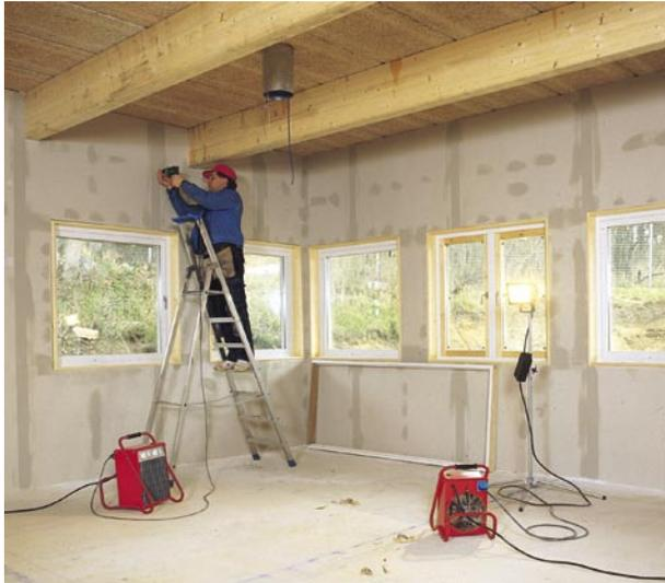
На задней стороне корпуса моделей P33, P53 и P93 имеется розетка на 230В~ для подсоединения любого инструмента и осветительных приборов. Незаменимы на строительных площадках!
