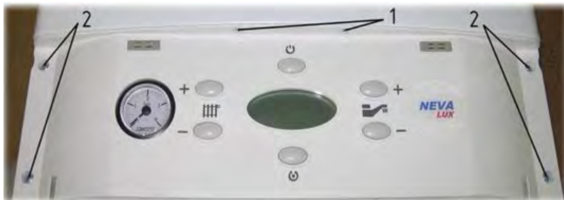
Рис. 13. Демонтаж облицовки и передней панели
