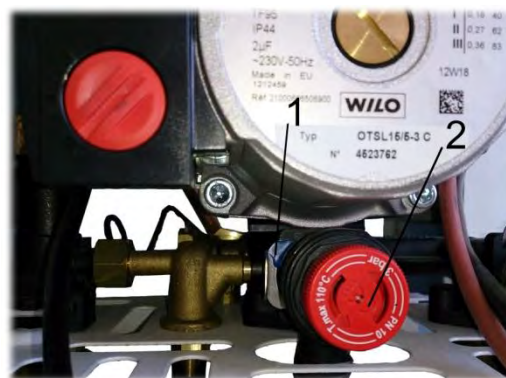
Рис. 21 Демонтаж предохранительного клапана
