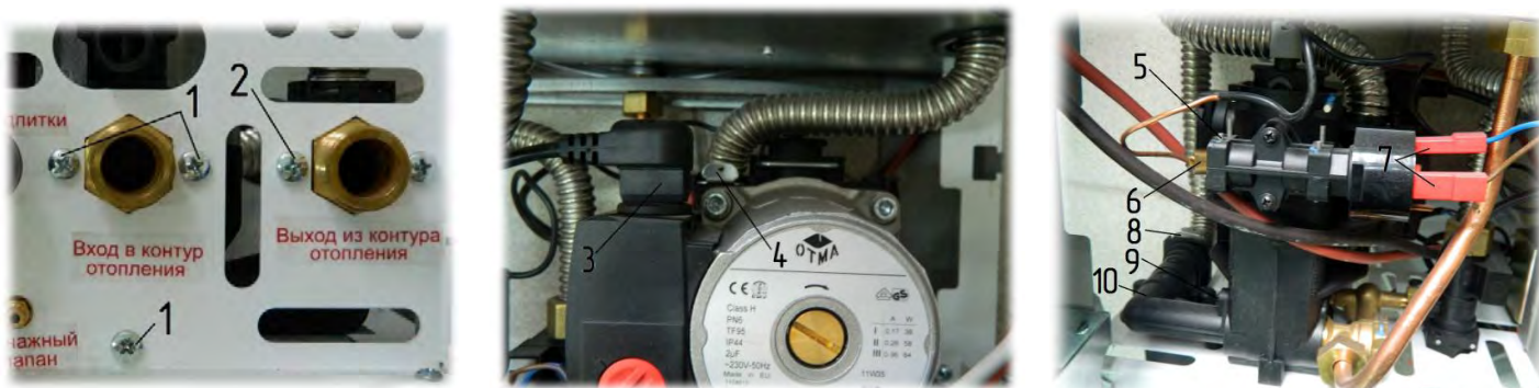
Рис. 17. Демонтаж насоса
