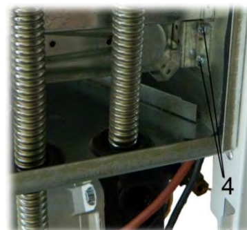
Рис. 15. Демонтаж блока горелочного
